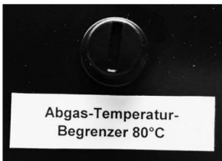
Sollte die Abgastemperatur über längere Zeit die Temperatur von über 80°C überschreiten, löst der Abgastemperaturbegrenzer aus.
